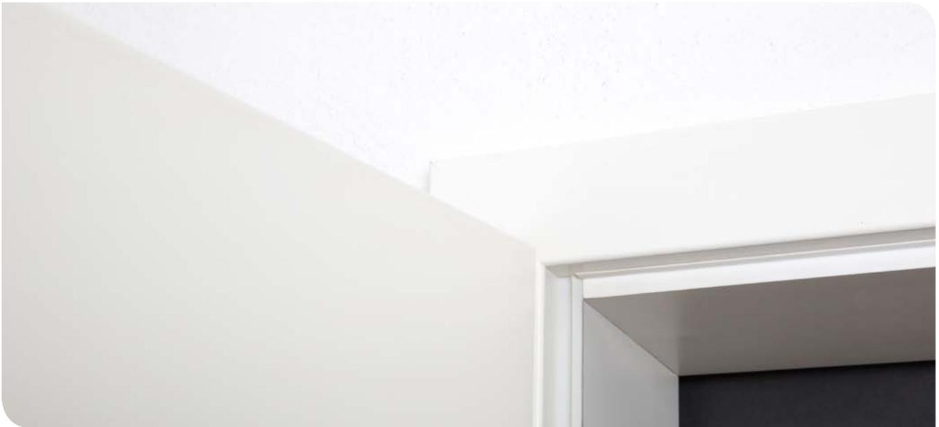
Mit der ÜSD wird das Thema Wohnungslüftung ganzheitlich betrachtet. Eine ÜSD wird statt der standardmäßigen Systemdichtung in die Aufnahmenut der Holz-Türzarge eingesetzt. Sie ermöglicht innerhalb der Wohnung das Überströmen der Luftmengen bei geschlossener Tür von einem
