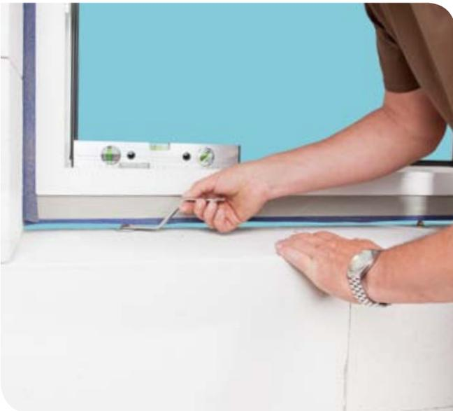
Der Tragteller JUSTA® TT und der Befestigungsanker JUSTA® BA bestehen jeweils aus einem flachen Metallteller bzw. einer flachen Ankerlasche, an dem/der eine Justierschraube und eine Justiermutter drehbar angebracht sind. Die Justierschraube wird mit einem Bit und einem
