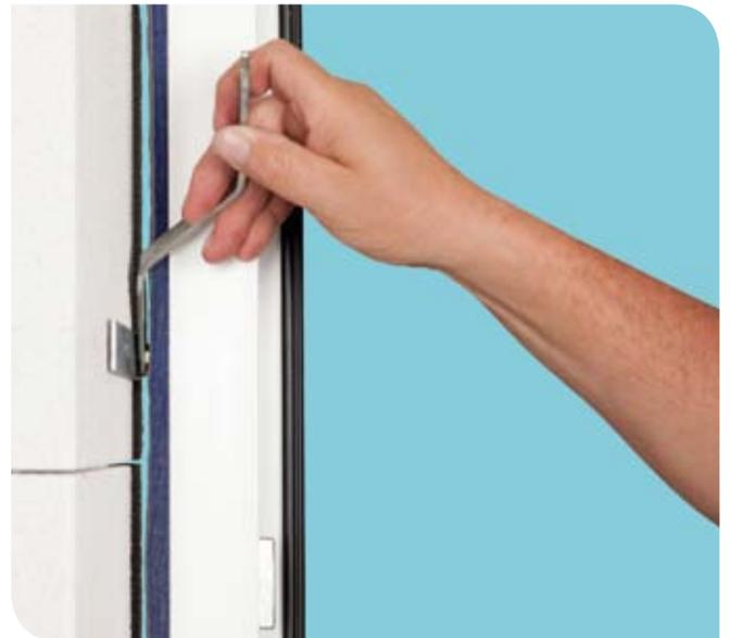
Elektroschrauber in die Blendrahmenunterseite eingedreht. Mit der Justiermutter wird das Fensterelement exakt ausgerichtet. Dazu wird mit dem hierfür konzipierten ratschenden JUSTA® Montageschlüssel geschraubt.
