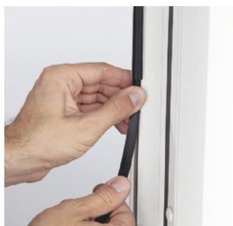
*Die Austauschdichtungen werden rechts und links in der Dichtungsaufnahmemenut des Fensterblendrahmens eingesetzt.*
