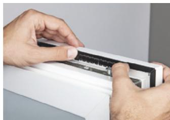
*Jetzt wird der Fensterfalzlüfter Arimeo mit festem Daumendruck so eingeklipst, dass die Lüftungsgklappen zur Glasscheibe zeigen.*
