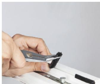
*Die Flügelüberschlagsdichtung wird nach der Größe des Fensterfalzlüfters rausgeschnitten und mit einer Spitzzange entfernt.*
